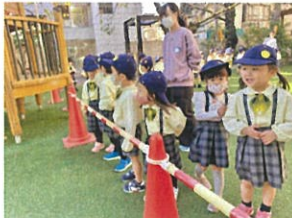
ツリーハウスの工事を 見守り中♡
