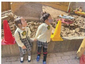
ツリーハウス工事中! いつもと違う光景に真剣に見ています! *
